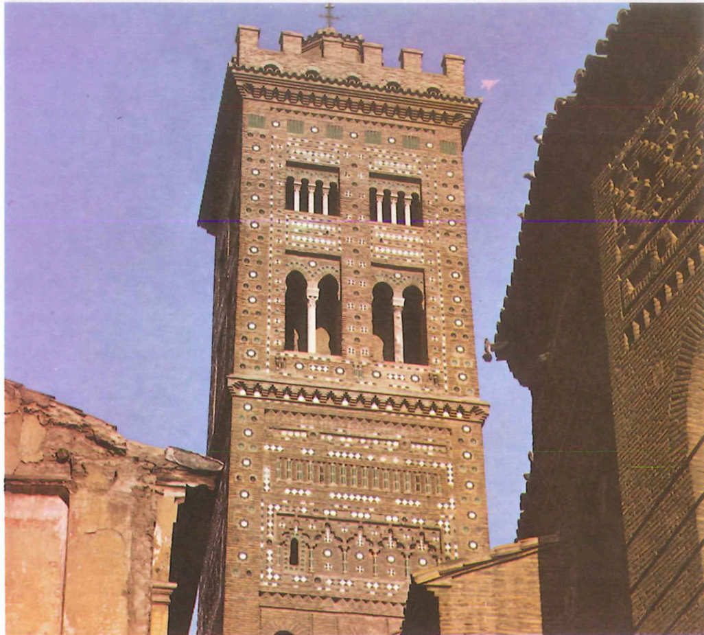
Torre mudéjar de la iglesia de la Magdalena de Zaragoza
